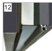
Czwarta przyłga i uszczelką samoopadającą (brak możliwości skrótów)
