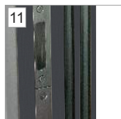
Przegroda termiczna, dwie uszczelki w ościeżnicy
